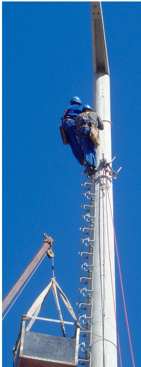
FIGURA 1 – Ilustração do Sistema de Escalada para Postes de Grande Altura sendo instalado em uma LT 230 kV urbana na cidade de Porto Alegre / RS.
