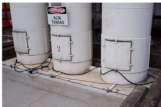
Figura 12. Posicionamento das bobinas de Rogowski na base dos dutos.
