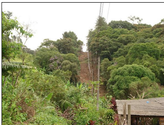
Foto 2: Exemplo da situação após a intervenção. Já com rede compacta ( spacer cable ). Facilidade de acesso das turmas de emergência e redução na interferência das árvores com a rede elétrica.
