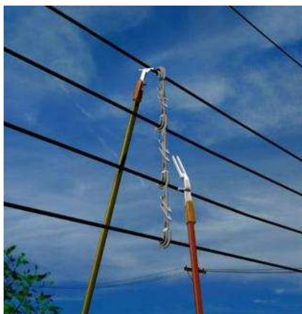
Figura 7 – Conexão do neutro e desengate da ferramenta
