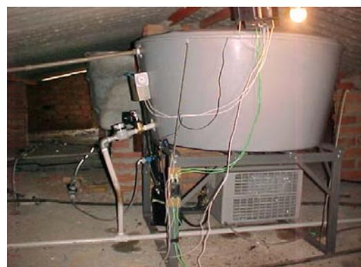
Figura 7. Detalhes do sistema de aquecimento, instalado, e tubulações hidráulicas e de fluido refrigerante.
