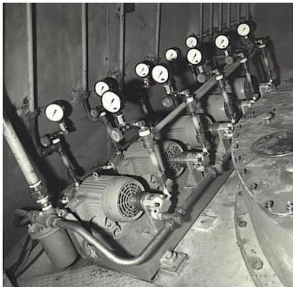
FIGURA 1 – Sistema Original de Moto Bombas de Injeção de Óleo
