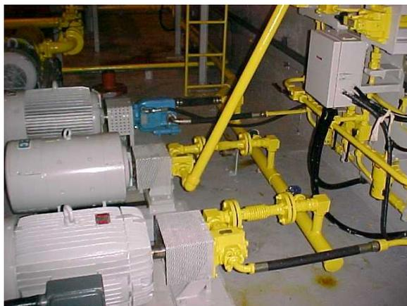
FIGURA 2 – Sistema de Moto Bombas de Injeção de Óleo
