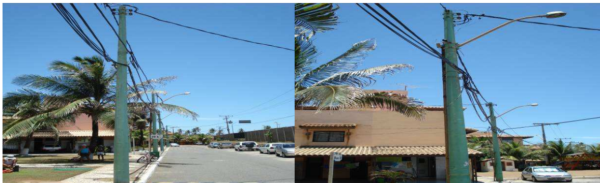
FIG. 7 – POSTE DE CONCRETO COM PINTURA EPOXI
