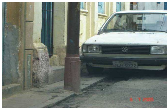
FIG. 9 – POSTE TUBULAR DE AÇO COM BASE RECUPERADA
