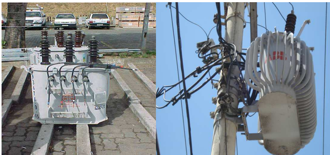
FIG. 12 - TRANSFORMADOR COM CABO DE SAÍDA PARA DOIS LADOS
