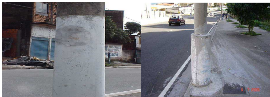
FIG. 5 – POSTE COM REFORÇO DE CONCRETO
