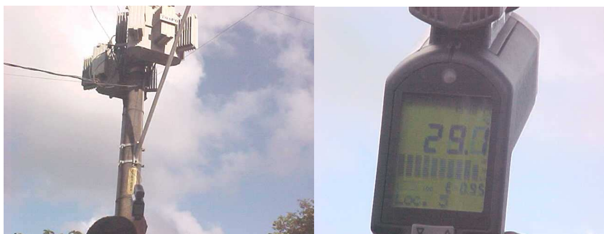
FIG. 1 – INSPEÇÃO DE TRANSFORMADORES COM PIRÔMETRO
