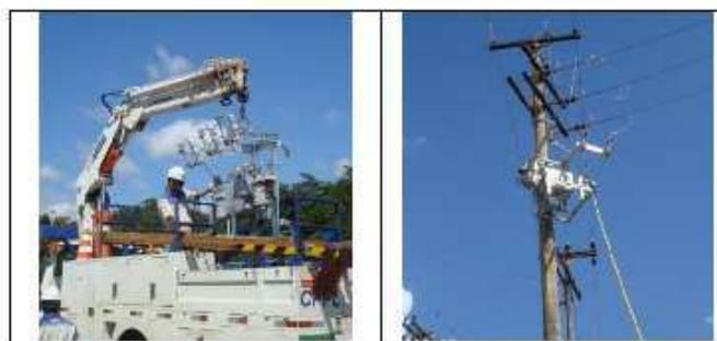
**Figura 7:** Instalação do Banco Sertãozinho
