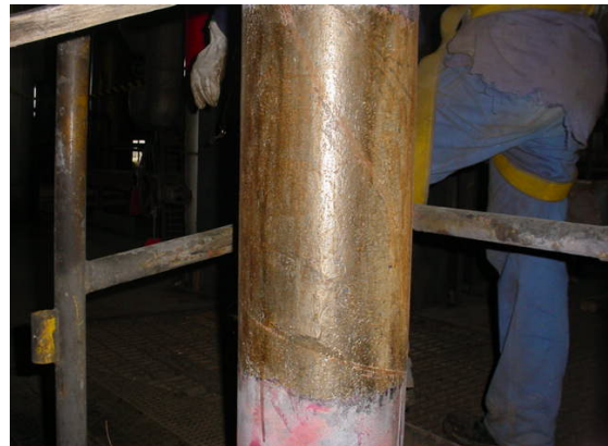
FIGURA 6 - Vista geral da Tubulação de Vapor do Superaquecedor.
