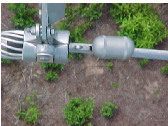
FIGURA 1 – Vibrógrafo instalado junto a grampo armado
