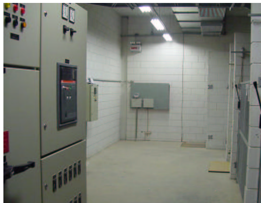
FIGURA VII PAINEL DE MEDIÇÃO EM UMA SE DE HIPERMERCADO
