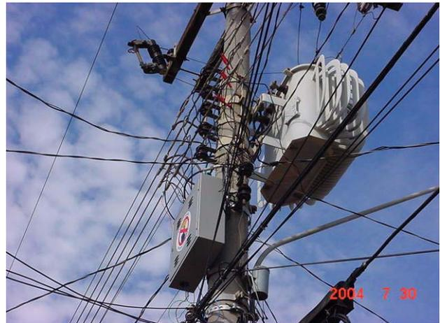
Figura 1. TOPAS 1000 instalado no secundário do transformador.
