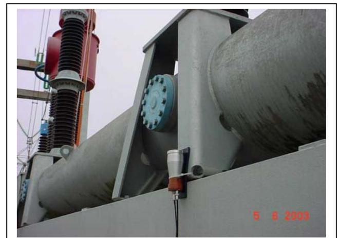
Fig. 9. Sensor receptor instalado na parte inferior do disjuntor.
