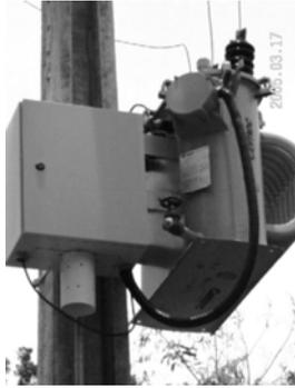
Figura 4. Transformador com sistema de aquisição de dados (UFC/DEE). Os dados do transformador são apresentados na tabela 1.
