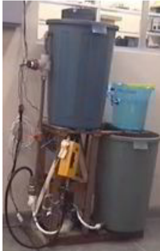
FIGURA 3 – Unidade OR-FV sem baterias
