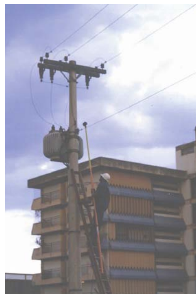
Figura 2. Operação de inspeção com sistema aéreo.
