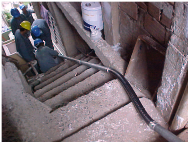
Detalhe da montagem eletromecânica
