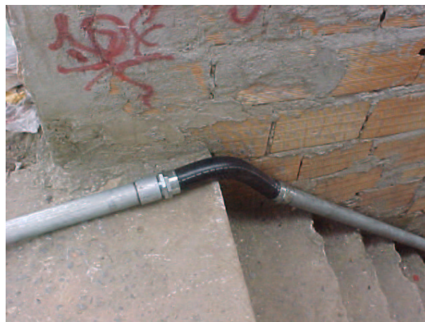
Trecho de uma RSSP em operação
