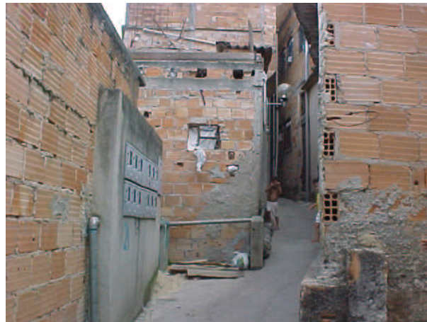
Conjunto de medição com ponto de iluminação pública
