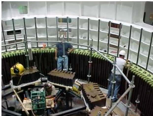
FIGURA 6: Prensagem intermediária do núcleo do estator
