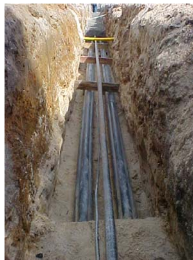
FIGURA 12 VISTA DO CORTE DE VALA NA ÁREA PILOTO ANTES DA APLICAÇÃO DO BACKFILL
