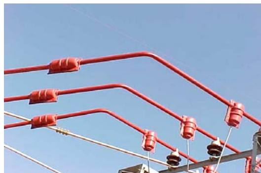
FOTO 9 – Tubos de alumínio com cobertura ( Piloto – SE Ibiá 2 )
