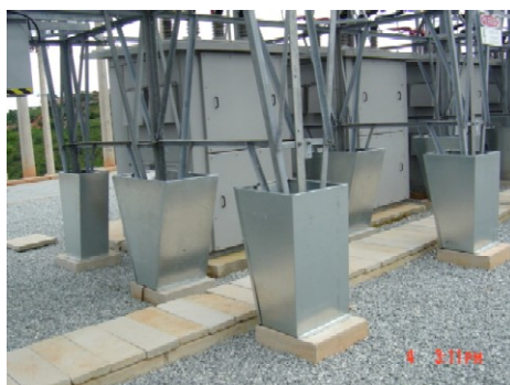
FOTO 1 – Pés das estruturas do setor 13,8KV com caixas metálicas contra subida de gambás e ouriços
