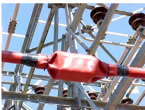
FOTO 6 – Conexão protegida com cobertura ( Piloto – SE Ibiá 2 )
