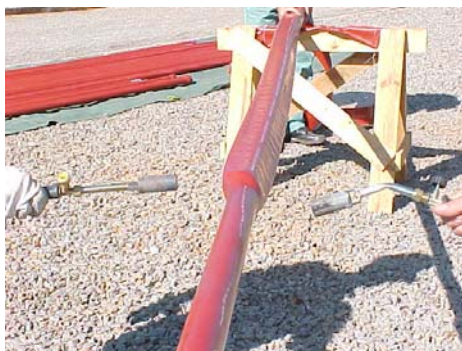
FOTO 8 – Instalação das coberturas nos tubos ( Piloto – SE Ibiá 2 )
