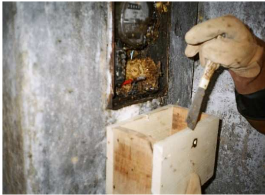
FIGURA 3 – Caixa simples sem módulo e sem pentes e de baixo custo Foto: Assunção, Lucélio Nativo da, 2005
