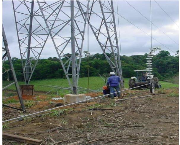
FIGURA 8 – Transferência de cabos
