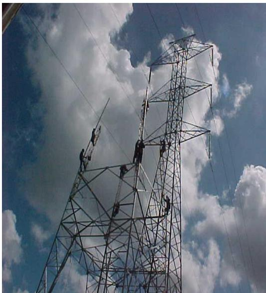
FIGURA 5 - Montagem das estruturas
