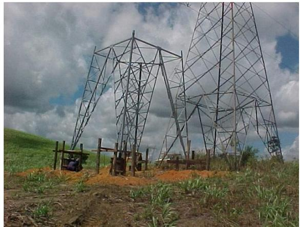
FIGURA 4 - Montagem quadro da base e concretagem
