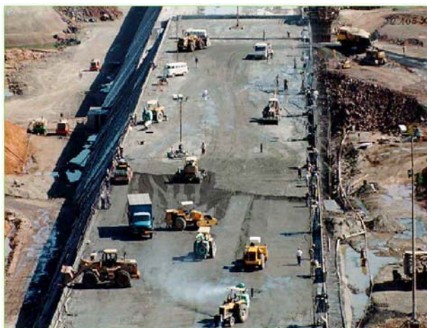
FIGURA 1 Vista Geral de uma Praça de CCR (Salto Caxias, estado do Paraná)
