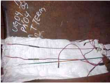
FIGURA-18- Resistências instaladas e cobertas
