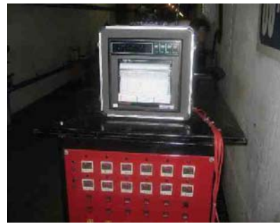
FIGURA-19- Equipamento de controle de temperatura
