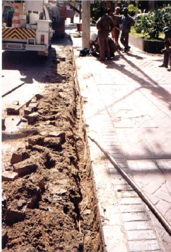
Figura 4 – Preparação da Malha de Aterramento para Instalação das Chaves Automatizadas.
