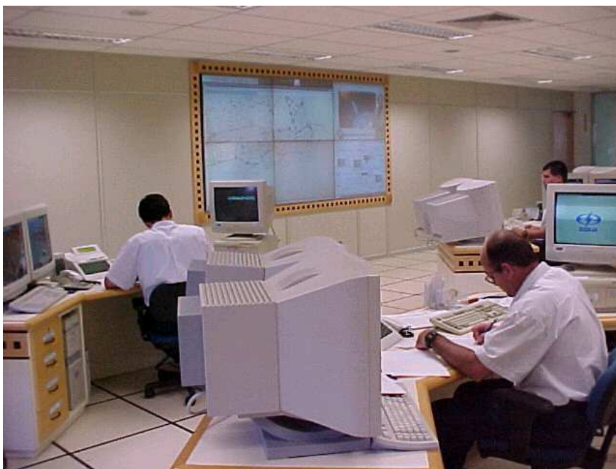
Figura 8 – Centro de Operação da ESCELSA
