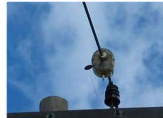
Figura 9a – Instalação do sensor com linha energizada , 9b – Sensor instalado e operando
