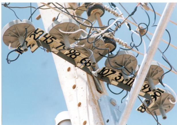
Figura 1 - Fotografia do interruptor anti-furto em uma de suas modalidades de fixação no poste.
