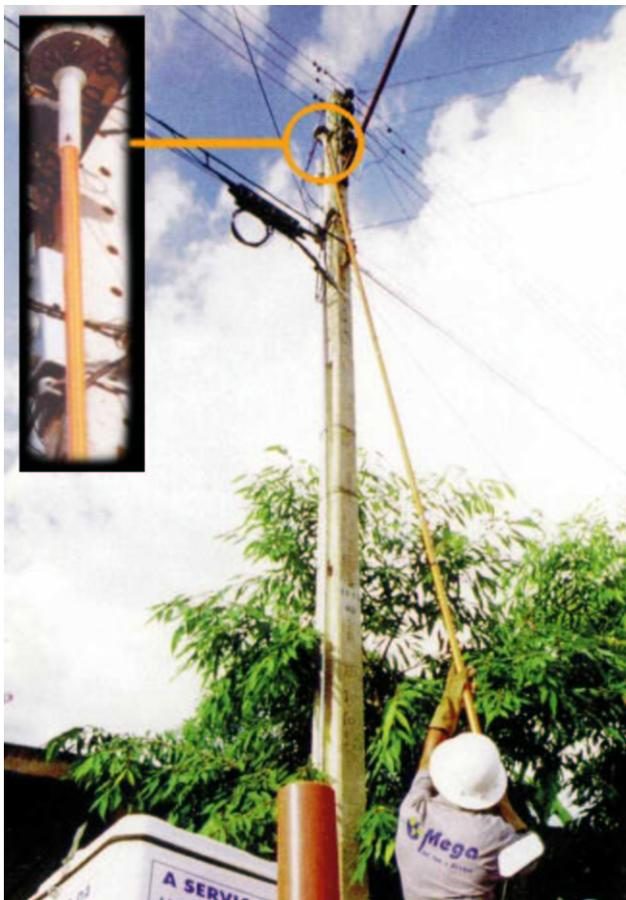
Figura 3 - Fotografia do interruptor anti-furto (exemplo) instalado, sendo acionado a partir do solo por vara de manobra na ponta da qual está acoplada a chave-segredo.
