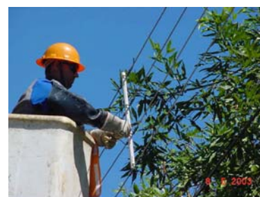
Figura 16 – Instalação de espaçadores
