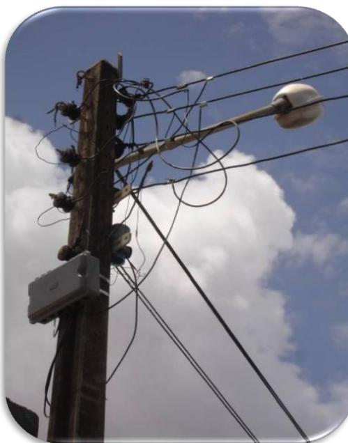
**Figura 5** – Protótipo instalado no poste da rede de distribuição para atendimento de duas UC **MONOFÁSICAS**
