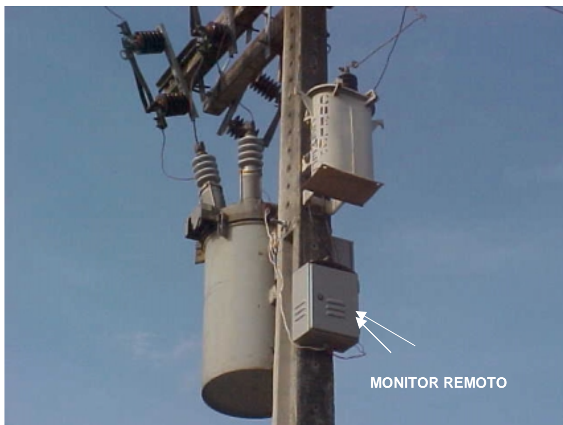
Figura 3 – Monitor Remoto Instalado junto a Religador KF
