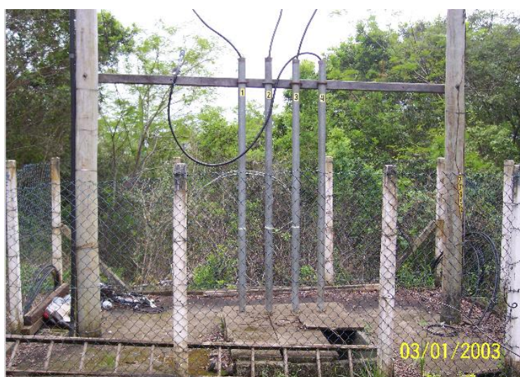
Imagem 1 – Barramento da Ponta do Funil antes da instalação.
