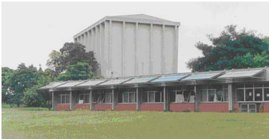
Figura 2. Sistema de 12 kW<sub>p</sub>, integrado na fachada do prédio da administração do IEE-USP.
