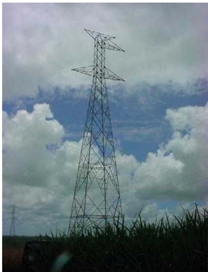
FIGURA. 3 Estrutura de Suspensão Autoportante tipo HLS3
