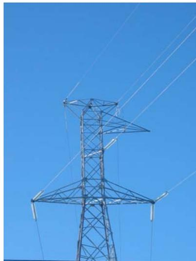
FIGURA 4. Estrutura de ancoragem autoportante tipo HLA40 e HLA60
