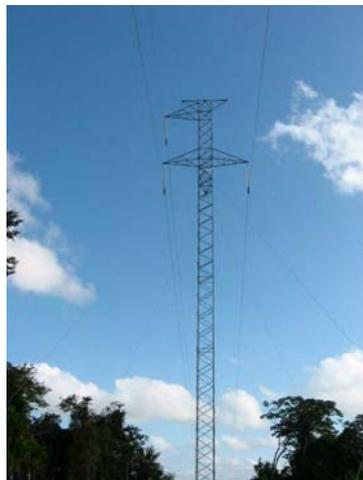
FIGURA. 2 Estrutura de Suspensão Estaiada HLES1/HLES2
