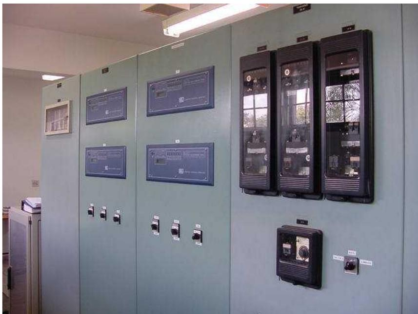
FIGURA 1 – Proteção digital Principal/Alternada e Eletromecânica
