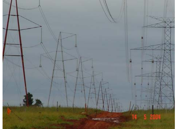
FIGURA 7 – Variante LT 440 kV com 71 torres Delta
