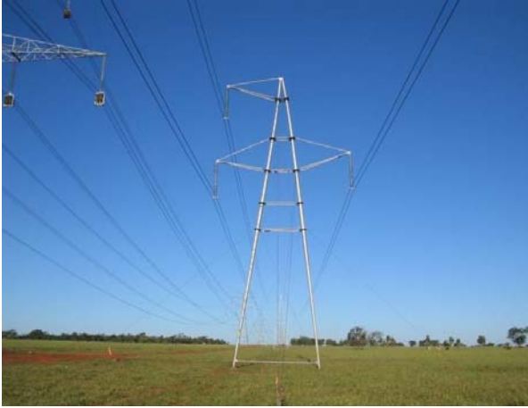
FIGURA 6 – Torre Delta em variante de LT 440 kV
