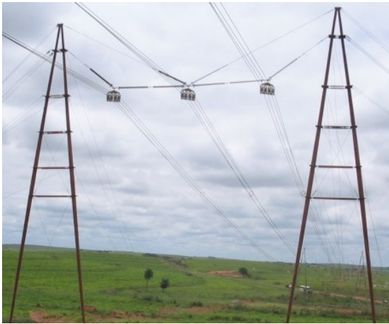
FIGURA 8 – Conjunto chainette com 2 torres Delta 440kV
