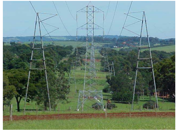
FIGURA 8 – Conjunto chainette com 2 torres Delta 440kV
