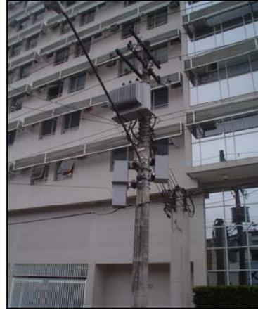
Fig. 12 - Segunda instalação do filtro com núcleo de ferro.
