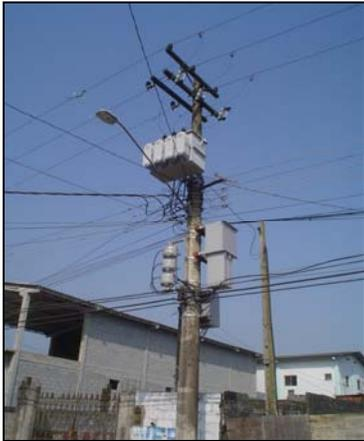
Fig. 10 - Segundo filtro de núcleo de ar com tamanho reduzido.
