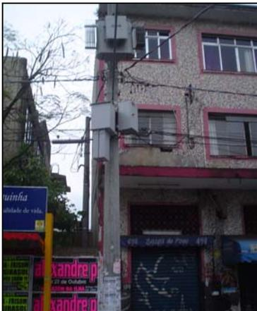
Fig. 11 - Primeira instalação com filtro com núcleo de ferro.
