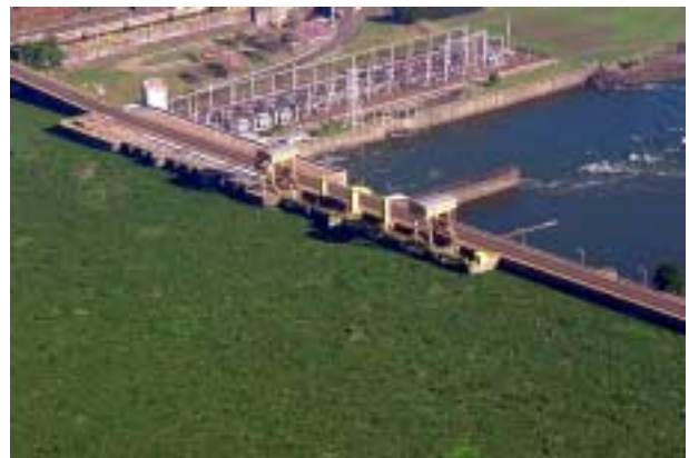
Figura 4 - Vista aérea da Usina Hidroelétrica de Bariri em 4 de junho de 2.001.
