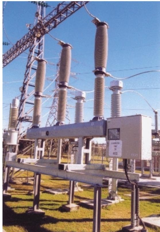
FIGURA3 Disjuntor 145 kV com mecanismo de acionamento tripolar: somente um cubículo integra o mecanismo de operação a molas, circuitos elétricos e DEI (SICU 3)
