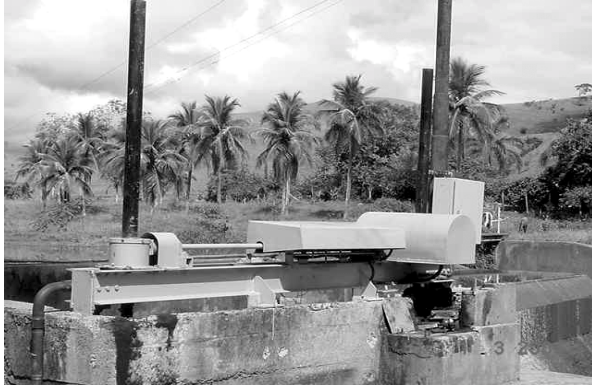
FIGURA 11 – Novo sistema de acionamento das comportas da tomada d'água.
