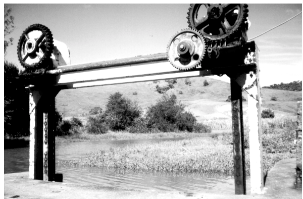
FIGURA 9 – Antigo sistema de acionamento das comportas da tomada d'água.
