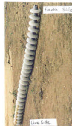
Figura 2: CORROSÃO SOBRE UMA CADEIA DE 500 kV SEM FERRAGENS DE PROTEÇÃO
