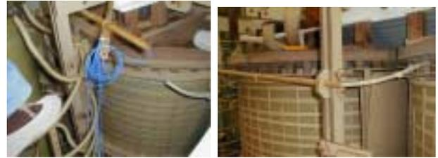
Fig 9 –Sensoreamento Ótico de Temperatura
