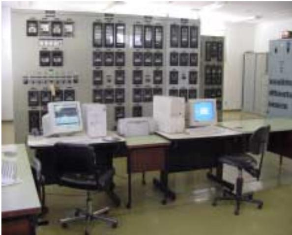
Fig. 5- Vista da Implementação na Subestação – Estação Servidora e Estação de Processamento da PCCD
