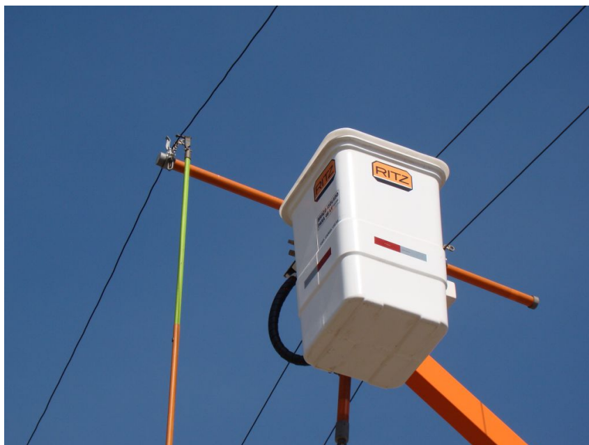
Figura 6 – Uso da Vara de Manobra Telescópica
