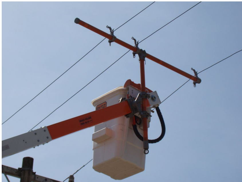
Figura 5 – Sustentação dos condutores
