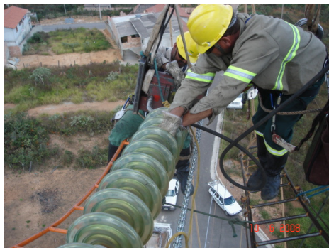
FIGURA 1 – Processo de grampeamento realizado com o condutor já lançado e regulado no vão da linha.
