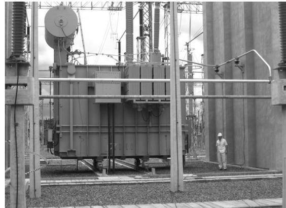
FIGURA 5 – Monitoramento do transformador de 200MVA, 525/230/13,8 kV da Subestação de Bateia.
