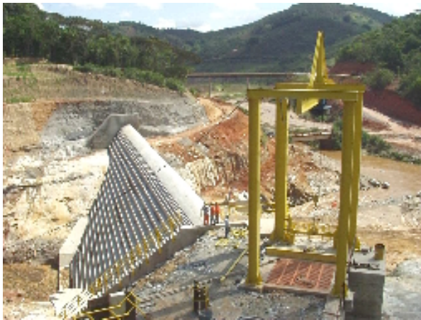
FIGURA 1 – BARRAGEM E TOMADA D'ÁGUA DA PCH FUMAÇA.
