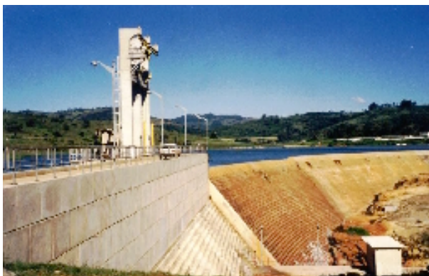
FIGURA 8 – VERTEDOR TIPO SOLEIRA LIVRE E TOMADA D'ÁGUA DA PCH RIO DO PEIXE.
