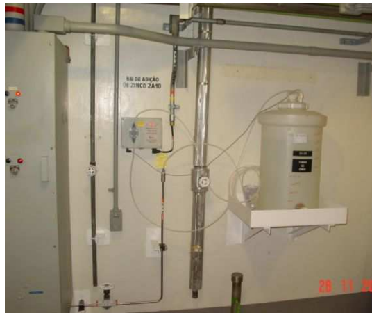
Figura 2 - Sistema de Adição de Zinco de Angra 1
