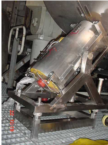
Figura 5 – Fotografia de uma instalação típica
