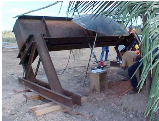
FOTO 2 – ENSAIOS DE TRAÇÃO EM ESTAIS
