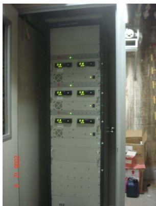
Figura 1 – Estação SmarTrunk de 3 canais em Itumbiara
