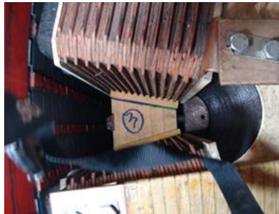
Figura 10: Conexão interpolar dos geradores de Ponte de Pedra.
