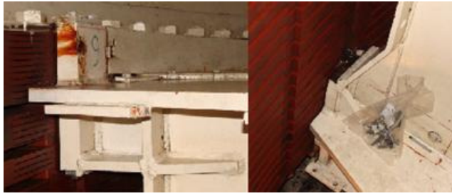
Figura 8: Sistema de enchavetamento da coroa dos geradores de Salto Santiago.
