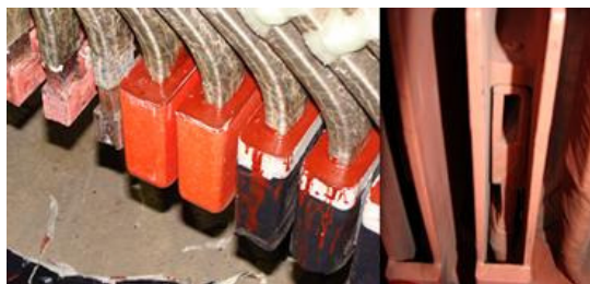
Figura 3: Isolamento e conexão dos lides das barras estatóricas.
