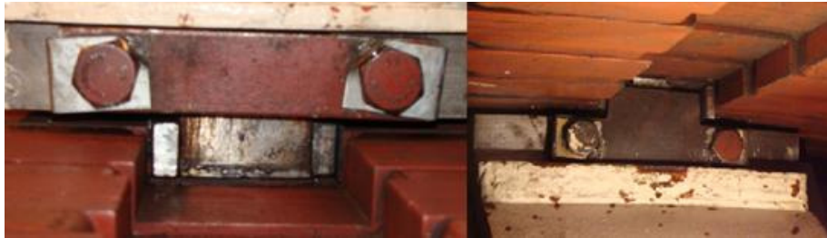
Figura 8 – (a): Detalhes do sistema de enchavetamento da coroa dos geradores de Salto Santiago.
