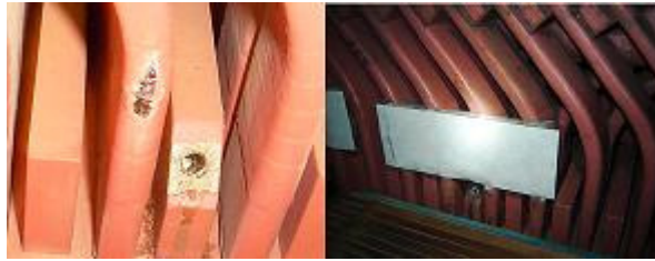
Figura 5: Roçamento das guias de ar no enrolamento e solução empregada.
