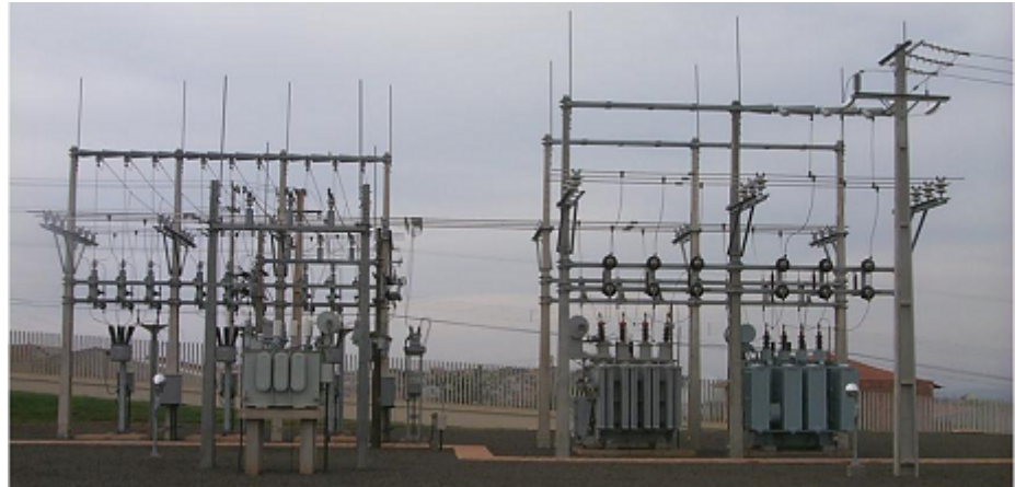
FIGURA 4 – Setores de uma SE 34/13 kV
